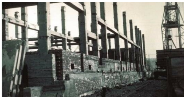
Рис. 6. Часть строящегося здания АБК на поверхностном фундаменте-оболочке в г. Норильск [Источник: https://kurl.ru/yQdKX ]
