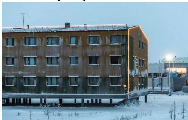
Рис. 5. Проветриваемое подполье в жилом доме [Источник: https://dzen.ru/a/ZF-4jF4IjXaBqpV7 ]
